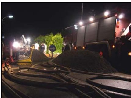
Bei Rohrleitungsarbeiten in Sautern kam es zu einem Problem mit dem zu hohem Grundwasserspiegel. Ein Bauunternehmen wollte ein defektes Rohr austauschen und während der Baggerarbeiten kam das Grundwasser zur Oberfläche und ermöglichte somit keine Weiterarbeiten.
